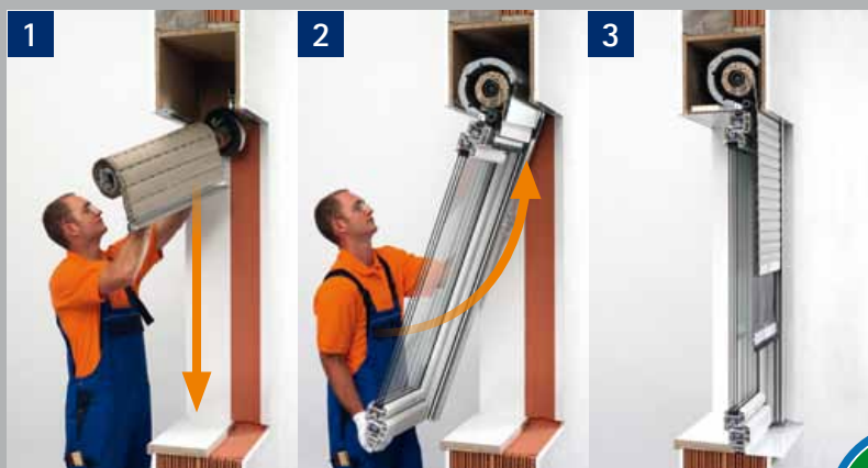
1 Alten Rollladen aus Kasten entfernen!
