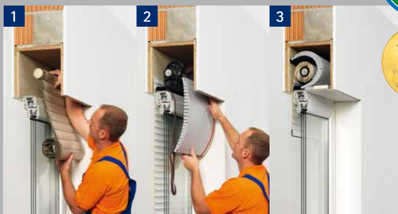
1 Alten Rollladen aus Kasten entfernen!
